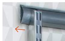
При установке несущего рельса учитывайте, что край рельса должен отступать от установленной направляющей на расстояние 10 -50 мм
